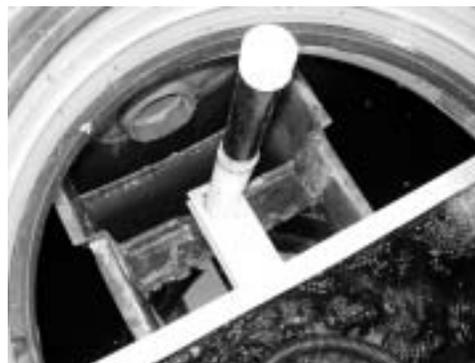
対策事例2 薬筒下部スリット調整（閉めすぎ注意）
