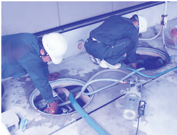
清掃するとともに、槽内の異常も確認する
