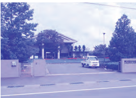
平成11年から供用開始された流域下水道処理施設
